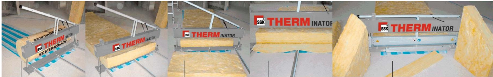
Anlegen der Mineralwolle
